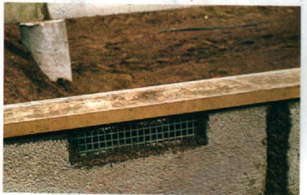
Les cales, en forme de coin, sont aussi en bois imprégné au CCA. Placées au dessus de la coupure de capillarité, elles sont clouées à travers la lisse basse. Leur débord est taillé au ciseau à bois. La lisse basse est dégagée du bord des fondations lorsqu'il y a un mur de doublure en briques de façade, par exemple.
