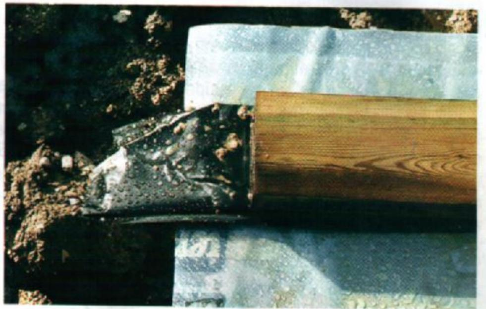
Ici un film PE transparent épais est d'abord posé au sol. Par dessous, un isolant en laine de verre gainé par un fourreau en film PE noir recyclé va rattraper tout défaut de planéité et empêcher toute pénétration d'air parasite sous la lisse basse.
